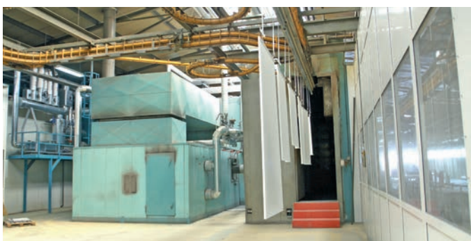
Für die Dampf-Beheizung musste in 6-8 m Höhe ein ca. 3,5 km langes Leitungsnetz installiert werden, links die Dampfleitungen, in der Mitte der umgerüstete und (für Notfälle dienende) Ölbrenner, rechts ein Einbrennofen. Quelle: Redaktion
